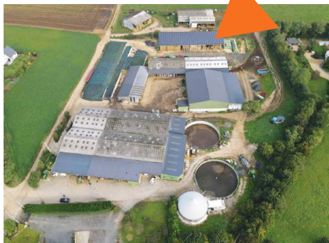
En plus des panneaux photovoltaïques, le GAEC des Papineaux (14), qui a accueilli les journées Grand Angle en 2022, a installé une unité de micro-méthanisation qui transforme les déchets de l'exploitation en biogaz.
